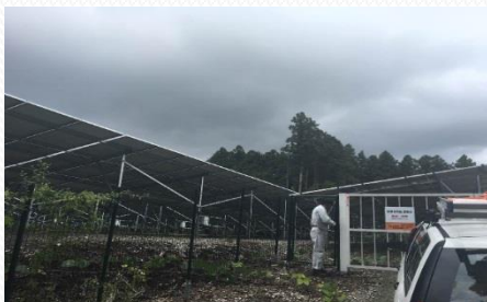
埼玉県本庄市 PCS: 日立 543.5kWシステム
