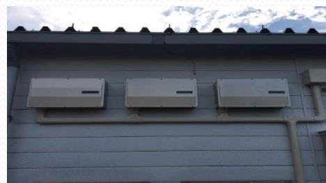
千葉県多古町 PCS:ダイヤモンド 16.5kWシステム
